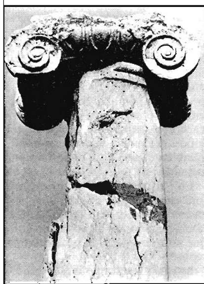
FOTO 2 Columna de un edificio público.
